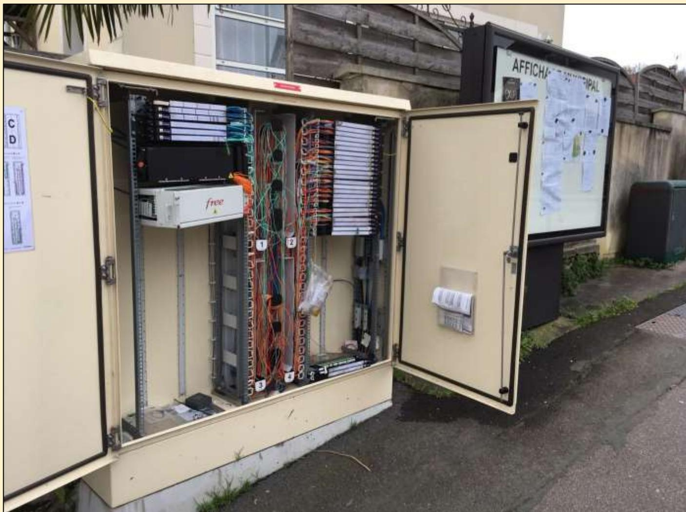
Il est fréquent de constater les armoires des points de raccordement portes ouvertes pendant des jours et des jours, exposées aux intempéries ainsi qu'aux sabotages éventuels.
